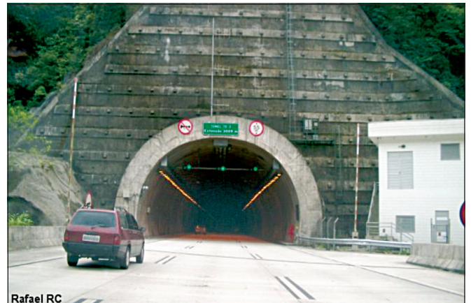
Figura 2: Sinalização na entrada do túnel
