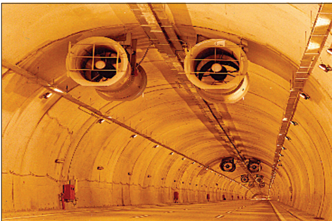
Figura 1: Sistema de ventilação longitudinal
